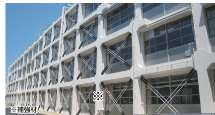
建物の「補強材」の型枠
