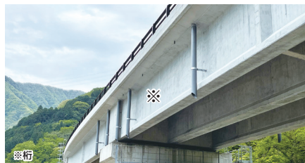
橋の「桁」の型枠
